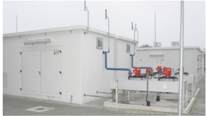
Sowohl das synthetische Methan als auch das mikrobiell gewonnene Biomethan gelangen über eine Einspeisestation ins Erdgasnetz.
