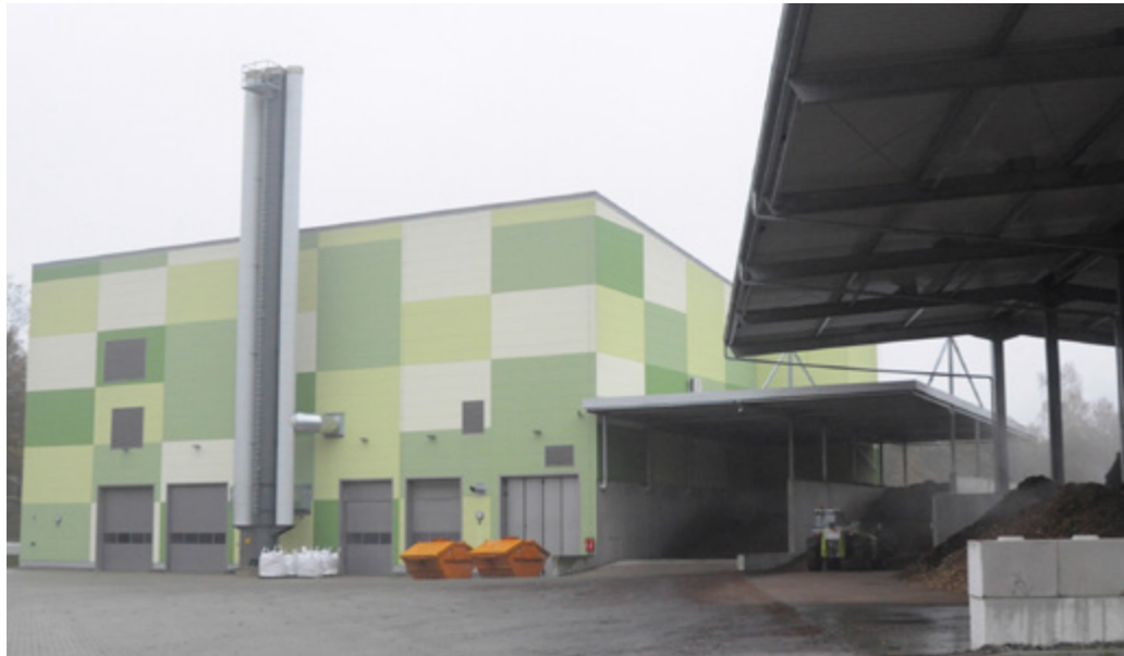
Für die Erzeugung von Strom und Wärme benötigt das Heizkraftwerk jährlich bis zu 70 000 srm Holzhackschnittel.
