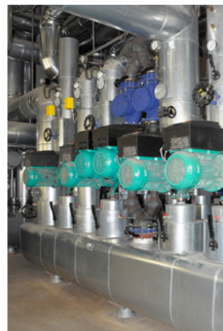
Mit der Wärme aufgeheiztes Wasser wird hier auf die einzelnen Kreisläufe des Nahwärmenetzes verteilt.
