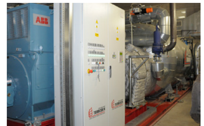
Zu dem ORC (Organic-Rankine-Cycle)-Modul gehört eine Dampfturbine (rechts), die den Strom erzeugenden Generator (links) antreibt.
