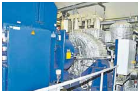
Die Dampfturbine treibt einen Generator an, der die mechanische Energie in Strom umwandelt.
