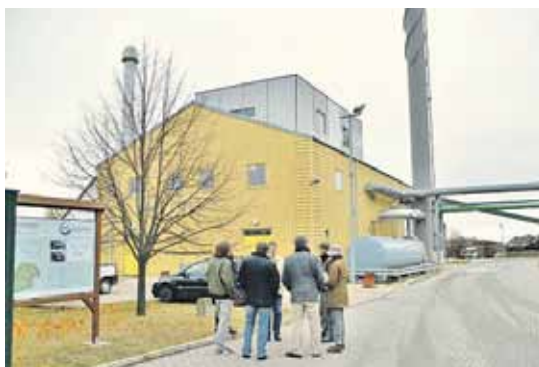
Das Biomasseheizkraftwerk hat eine elektrische Leistung von 5,36 MW.
