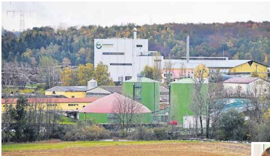
Sowohl die Biogasanlage der Agrargenossenschaft als auch das hinter ihr stehende Heizkraftwerk erzeugen aus unterschiedlichen Biomassen neben Strom auch viel Wärme.
